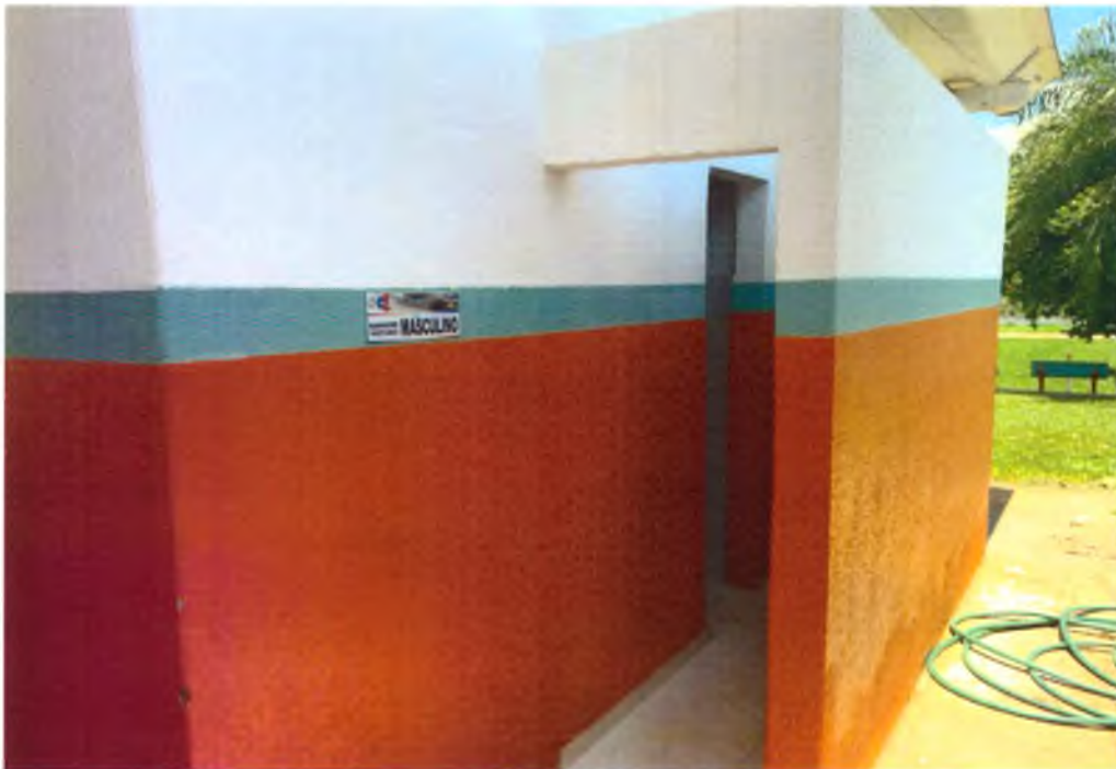
Foto 08: Acesso aos Sanitários.
