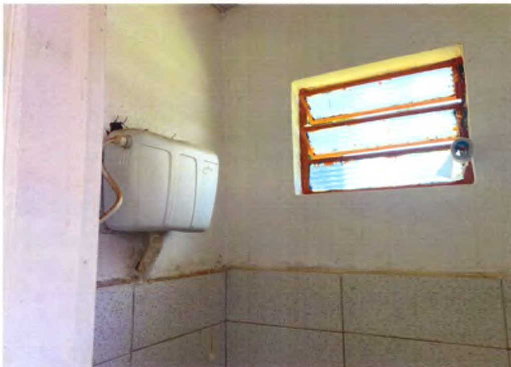
Foto 14: Caixa de descarga banheiro feminino.
