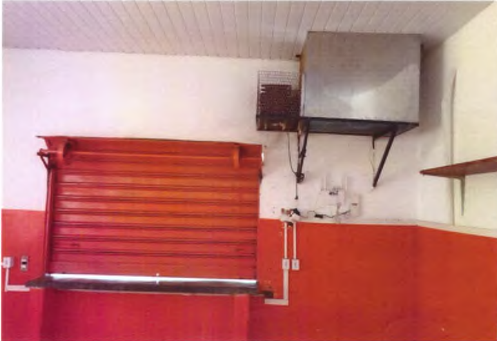
Foto 17: Boqueta metálica para passagem de comidas, bebidas e motor de refrigeração do bebedouro.
