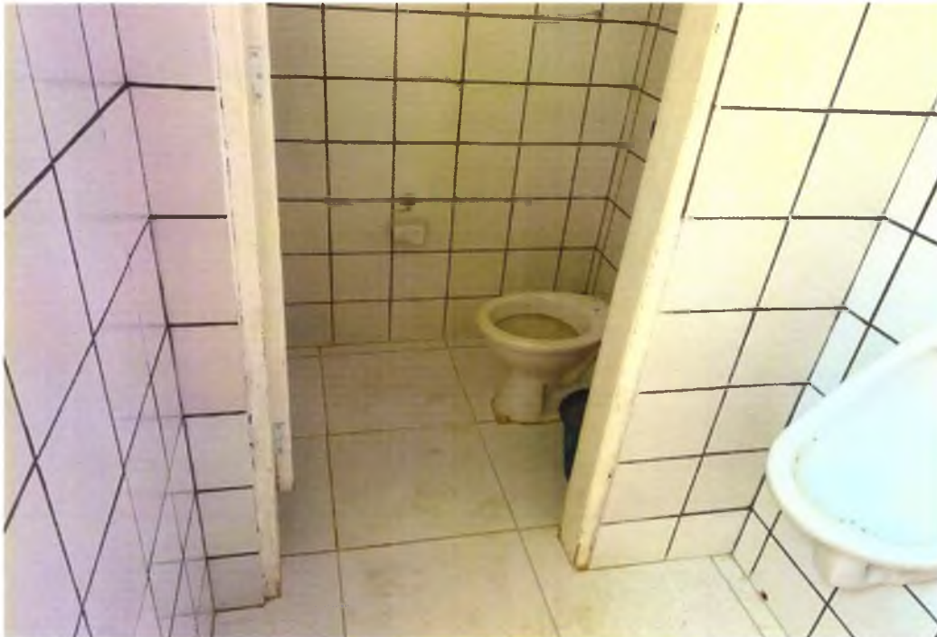
Foto 10: Banheiro masculino – mictório e vaso sanitário.
