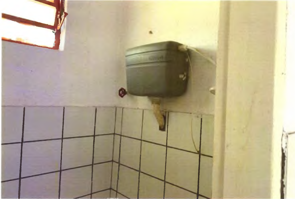
Foto 11: Caixa de descarga banheiro masculino.
